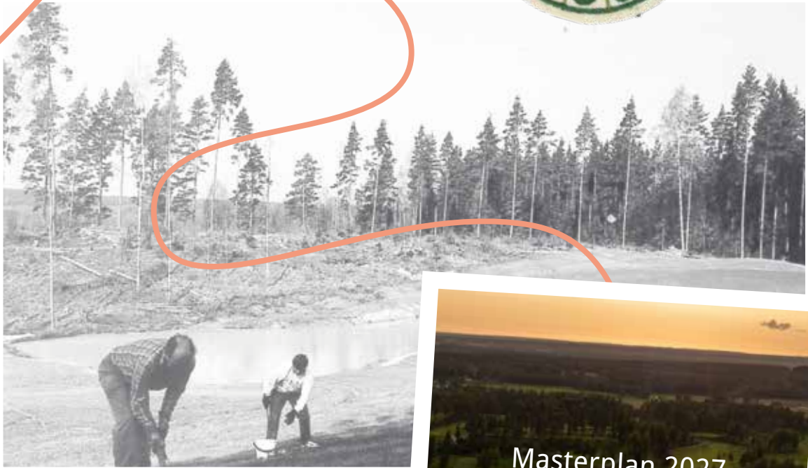
Arbete vid bygget av gul slinga
